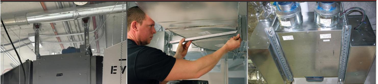
TopSupports est un profilé fabriqué d'acier galvanisé (G90) facilitant l'installation et le renforcement séismique pour multiples applications telles que ventilation, électricité, plomberie, réfrigération et protection d'incendie.
